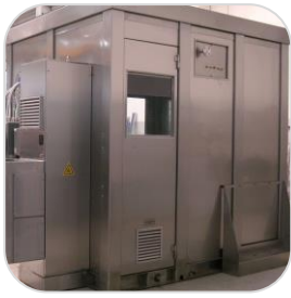
Shelter EEx p Raffineria Gruppo ENI
