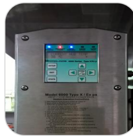
Dettaglio Sistema EEx per Area Pericolosa
